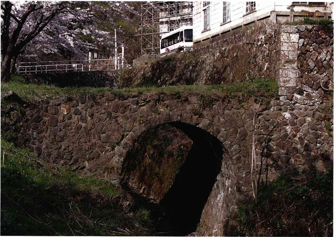
明治に入り、鉱山の設備は近代化された。切石によるアーチ積みとモルタル・切石による「タタキ工法」で造られたこの橋には「佐渡鉱山 三十七年……」の銘板が残る。
